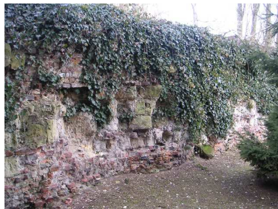
Zuidwestelijke muur (binnenzijde)
