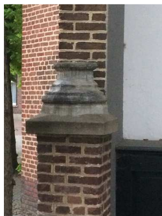
Bouwfragment, omgekeerd Maaskapiteel (zeer waarschijnlijk afkomstig) van het kasteel gebruikt op de linker altaarpost van de St. Rumolduskapel aan de Molenpoort.
