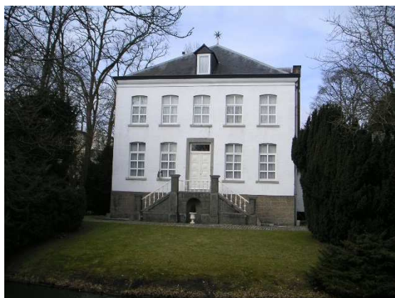
Herenhuis in classicistische stijl, gebouwd op de fundamenteën van de Zuid-westelijke verdedigingstoren. Daaronder ondermeer de nog geheel intacte kanonkelder.
